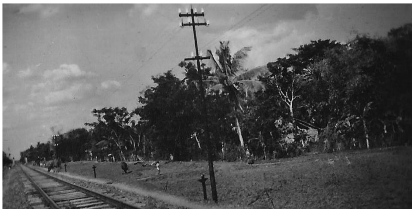
📅26/1/1948. Overgeplaatst veldpostkantoor Semarang.
