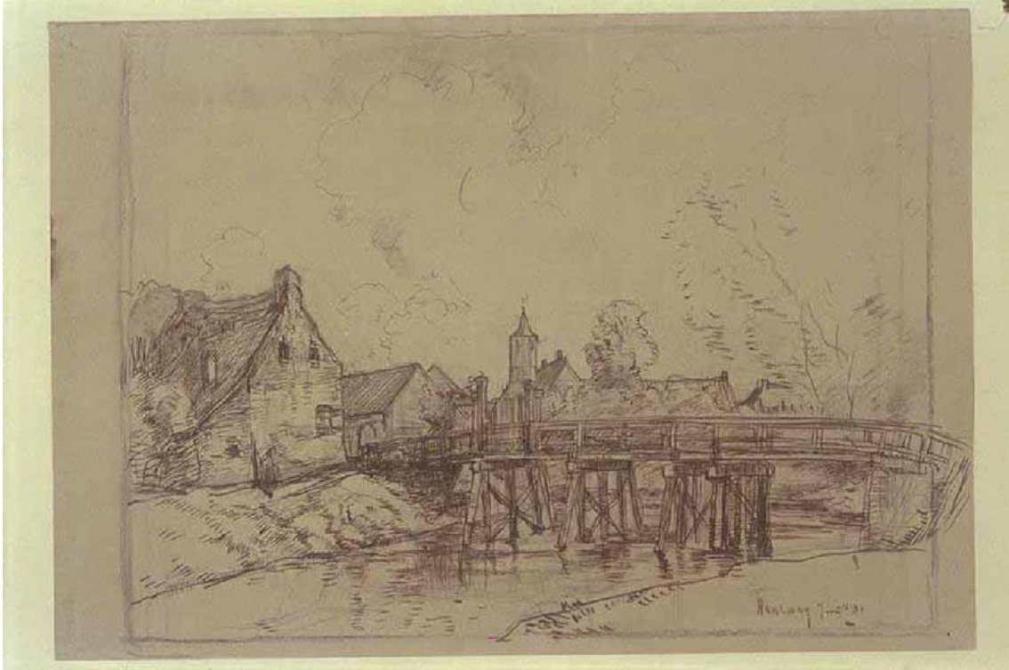
Houten brug van Halder naar Haanwijk (1931 P. Sluiter)
