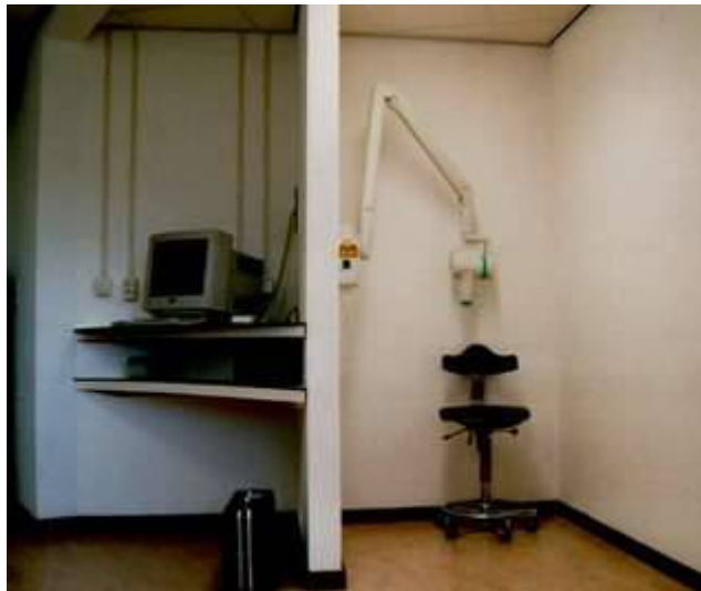
Figuur 13.1. Goedgekeurde opstelling voor een Tandheekkundiġ röntgentoestel.
