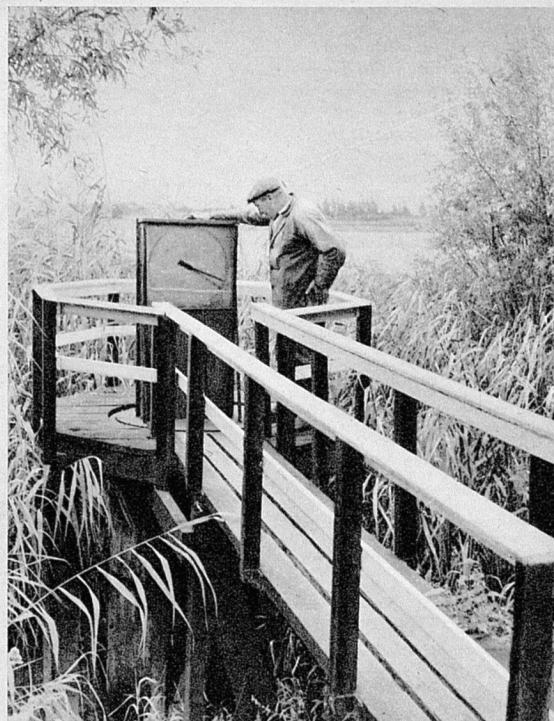
Watermeter F. de Gier, die met behulp van een peilschaal tweemaal per dag de waterstand van de Lek ter plaatse meet.
